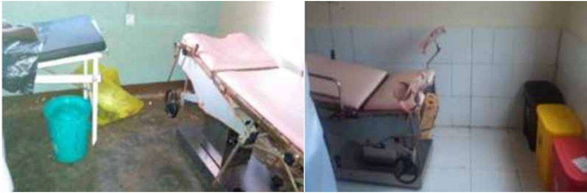
設備改善のピフォーアフター 1 ルウェロ地区、ジロブウェ保健センターIII タイルが貼り替えられ、廃棄物が分別された
