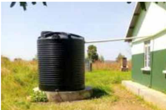
オナー保健センターIIに設置された 雨水貯蓄タンク
